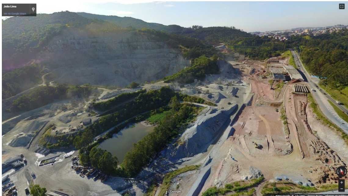
Figura 7. Foto aérea das obras do Trecho Norte do Rodoanel
